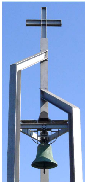
Glockenturm St. Katharina, Oberhausen-Lirich, Foto: THE
